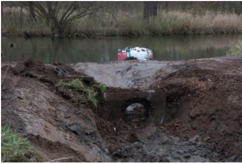
Das alte, inzwischen marode Einlassbauwerk für die Papitzer Lachen wurde ausgetauscht.
